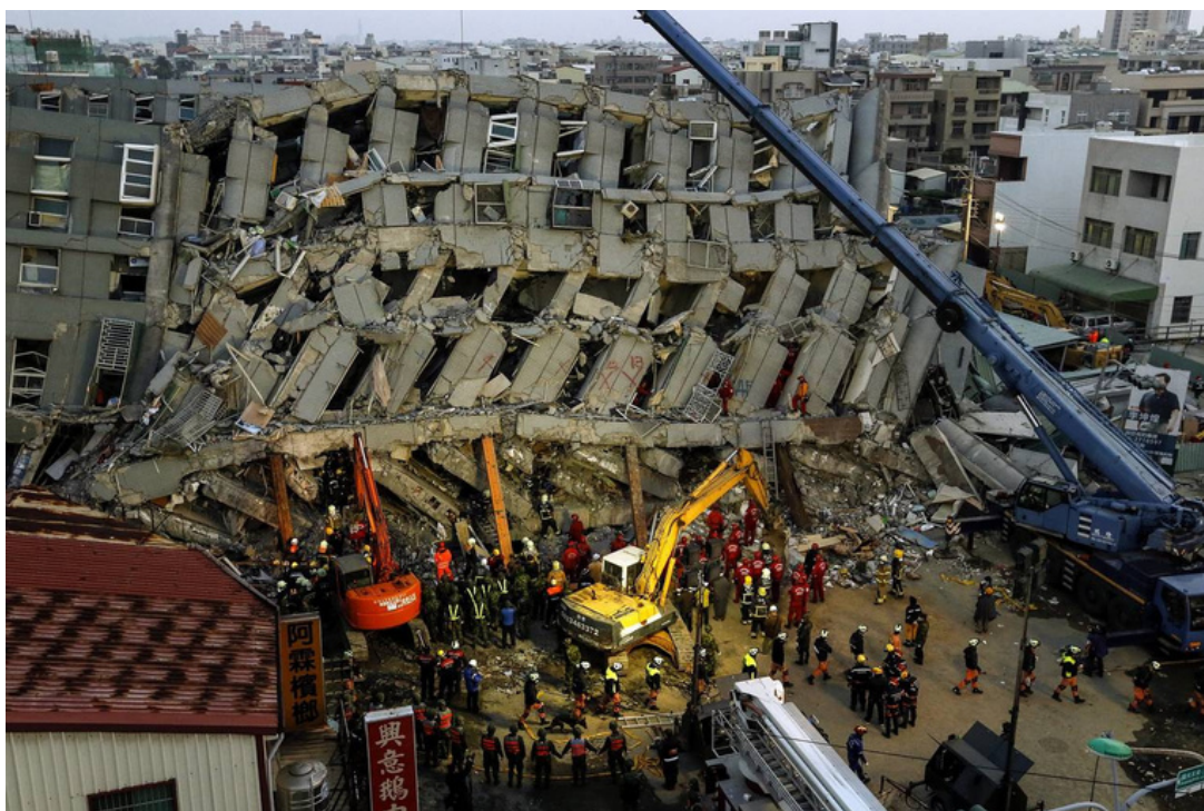
Clădire prăbușită la cutremurul din 06.02.2016, în Taiwan, Mw 6.4 Sursă: https://www.wsj.com/articles/taiwan-officials-launch-rescues-1454816862
